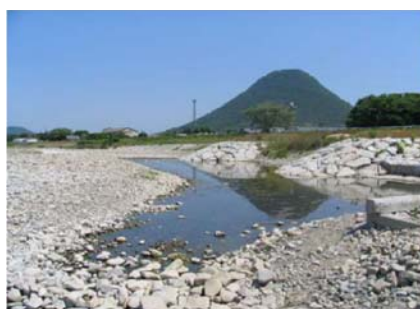
長尾地区 環境水制工 (河口より8.4k付近左岸)
