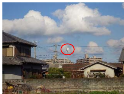
③地点からの鉄塔視認状況 (鉄塔から約450m)
