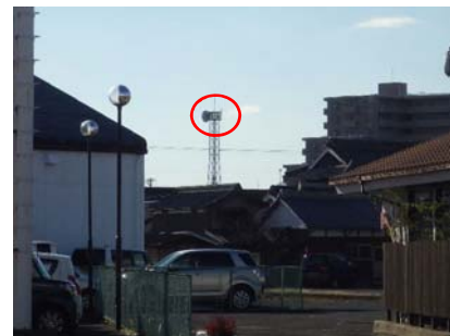
①地点からの鉄塔視認状況 (鉄塔から約800m)
