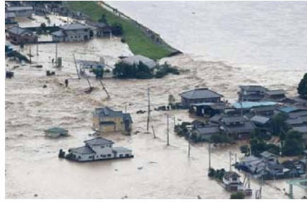
鬼怒川堤防決壊(茨城県)H27.9
