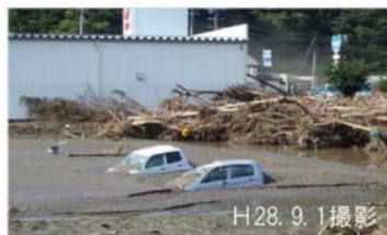
小本川 被害状況②
