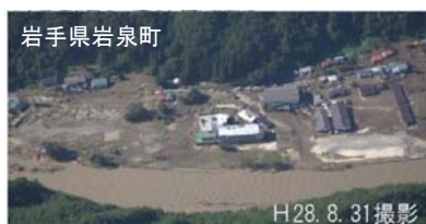
小本川 被害状況①
