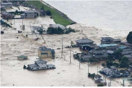
鬼怒川堤防決壊(茨城県)H27.9
