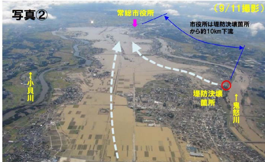
鬼怒川被害状況写真（提供：国土交通省関東地方整備局）
