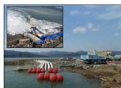
排水ポンプ車(排水能力毎分150m³ 東北最大級)による作業
