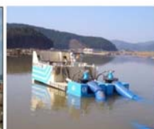
排水ポンプ車(排水能力毎分45m³ 無線操縦自走式)による作業
