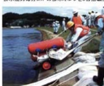
ポンプは人力で水中に投入できるように軽量化。
