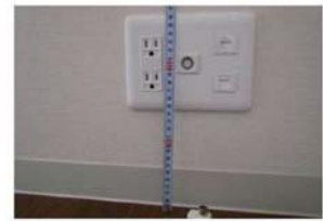
床から20cmに差込口がある コンセントとモジュージャック
