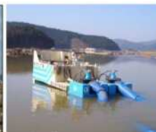
排水ポンプ車(排水能力毎分45m³ 無線操縦自走式)による作業
