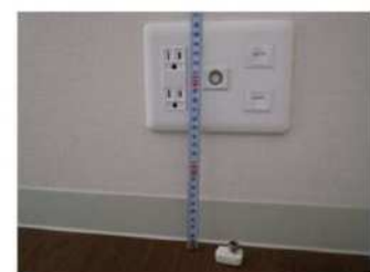
床から20cmに差込口がある コンセントとモジュラージャック
