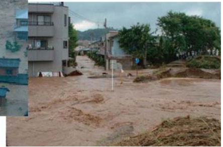
足羽川堤防決壊(福井県)H16.7
