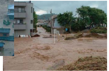
足羽川堤防決壊(福井県)H16.7
