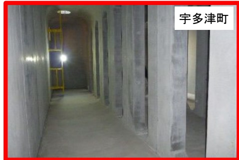
雨水貯留槽の内部状況
