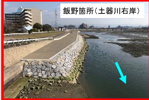
堤防整備状況
