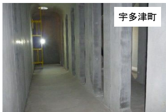
雨水貯留槽の内部状況
