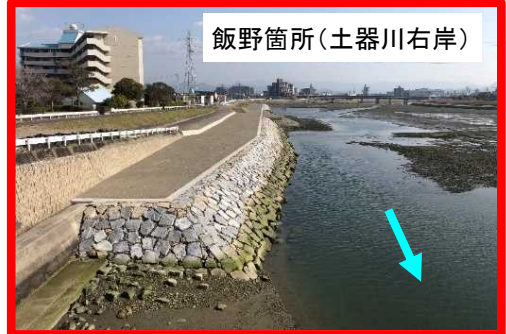
堤防整備状況
