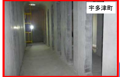
雨水貯留槽の内部状況
