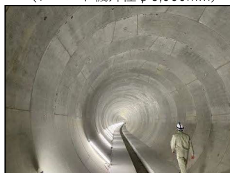
雨水貯留管内部 (仕上がり内径φ5,250mm)
