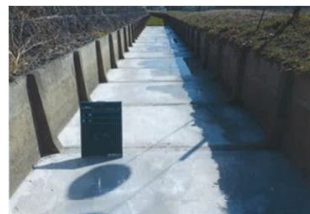
底張りコンクリート
