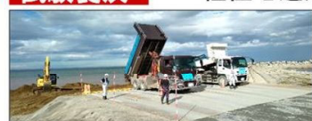
養浜材の荷下・投入状況 (R4.8.18 撮影)
