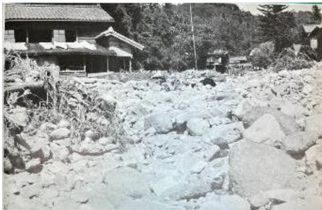
「羽越水害」の被害写真
