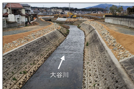
広島県による支川の改修 大谷川
