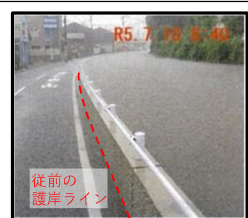
<池町川護岸嵩上げ>
