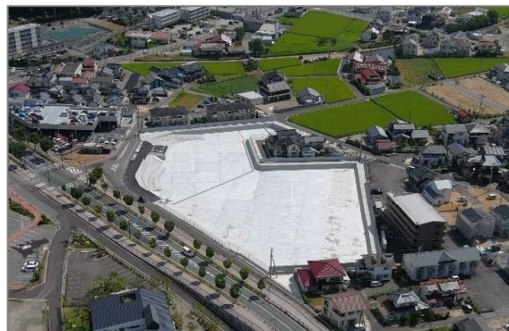
三次市による雨水貯留施設の整備
