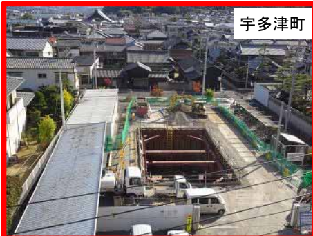
雨水貯留施設整備
