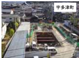
雨水貯留施設整備
