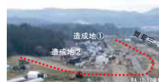
移転家屋の建設が進む状況
