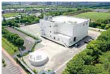
雨水ポンプ場
