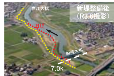
引堤(石川県梯川水系梯川)
