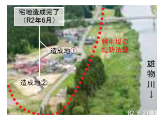
移転先宅地造成完了状況
