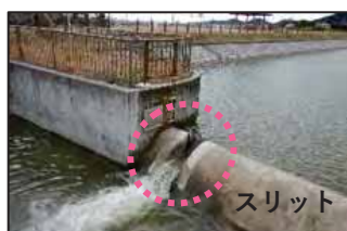
▲スリットの設置状況
