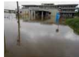
浸水時の状況 (喜多方市提供)
