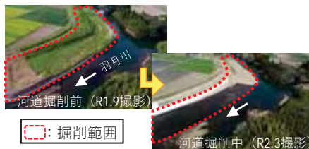
河道掘削(鹿児島県内川水系羽月川)
