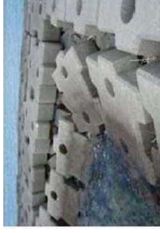
突堤の被覆ブロックの散乱事例
