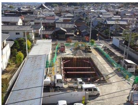
【雨水貯留施設整備】
