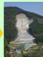
山腹工 施工直後の様子 (平成22年10月撮影)
