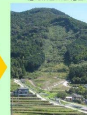
山腹工 施工後9年後の様子 (平成30年9月撮影)
