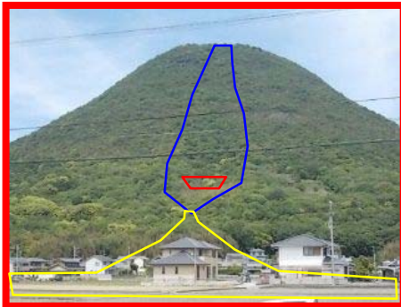
砂防堰堤整備
