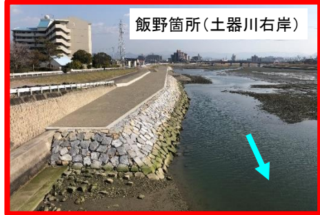
堤防整備状況
