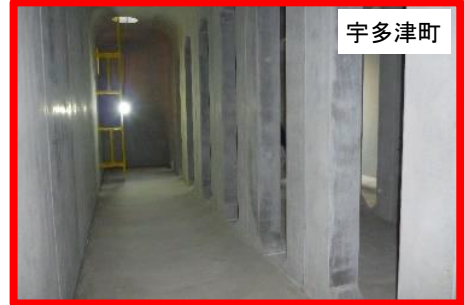
雨水貯留槽の内部状況
