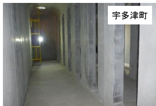
雨水貯留槽の内部状況
