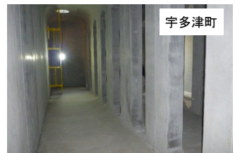
雨水貯留槽の内部状況
