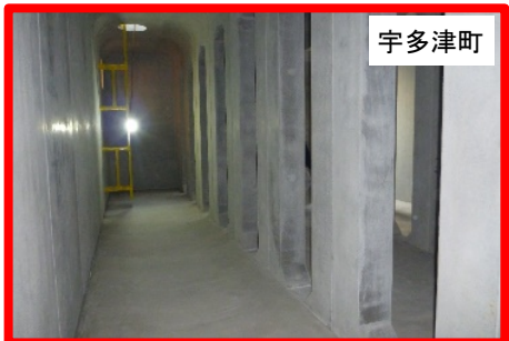
雨水貯留槽の内部状況
