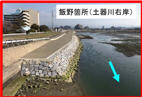
堤防整備状況
