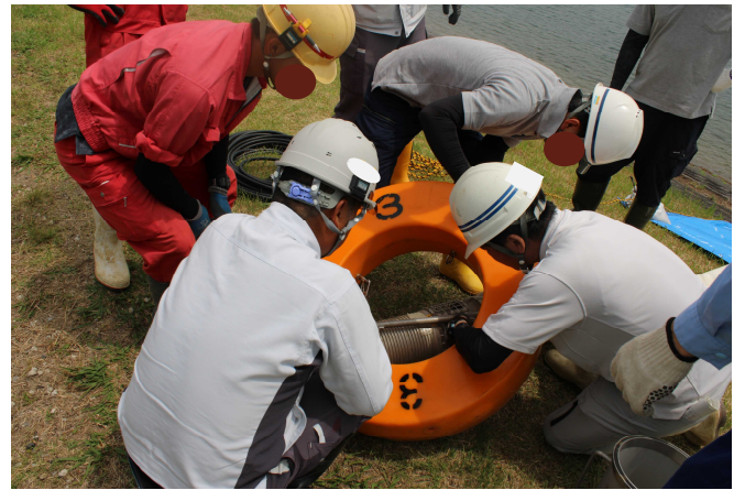
排水ポンプにフロートを取付
