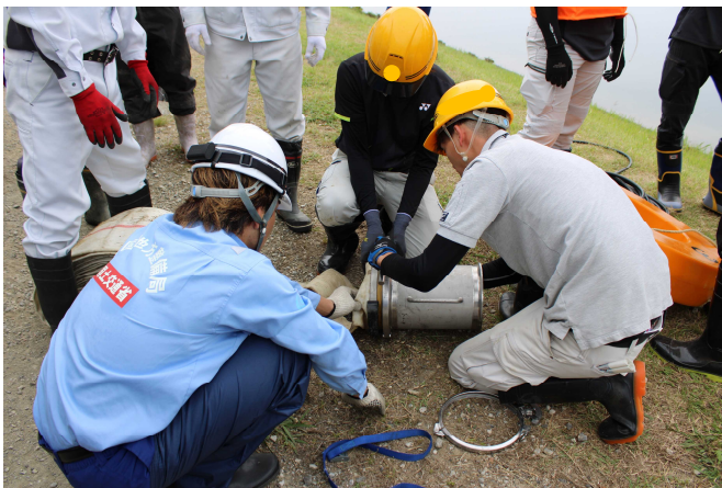
排水ホース接続状況
