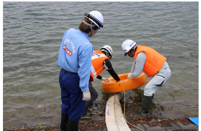
排水ポンプ投入
