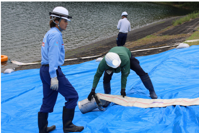
排水ホース設置
