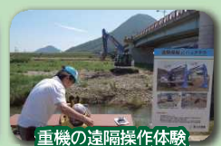
重機の遠隔操作体験
