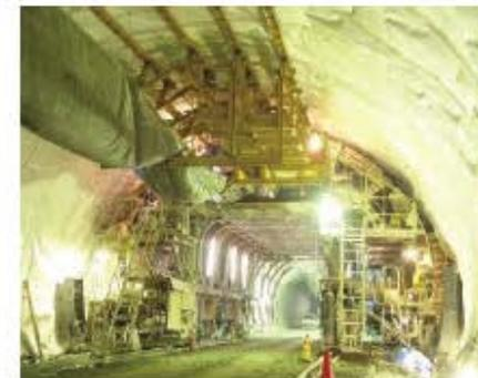
トンネルをコンクリートで仕上げるための鋼製の大きな型枠です。一回の施工で約10mの覆工コンクリートを打設することができます。
