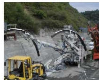
鋼製支保工をつかむ2本の腕と吹付けバウルを装備した機械。鋼製支保工建込みと吹付けコンクリート作業に使用し、素早く地山を固めます。
