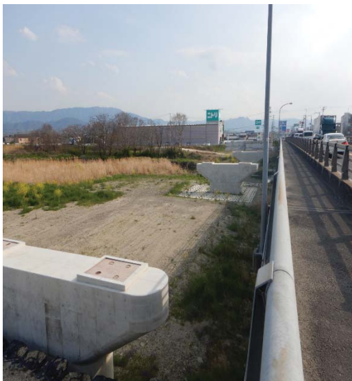
本山橋の下部が完成しました。
