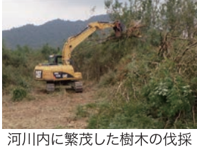
河川内に繁茂した樹木の伐採
