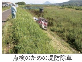
点検のための堤防除草
