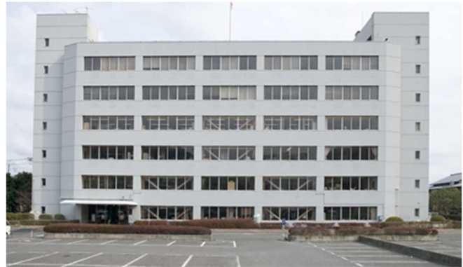
徳島地方合同庁舎 (既存庁舎)
