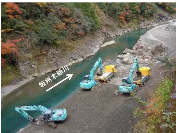
堆砂除去工事実施状況
