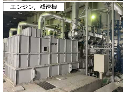
老朽化した雨水ポンプ設備
