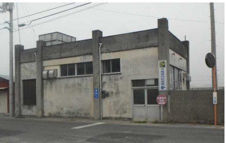
老朽化した雨水ポンプ場
