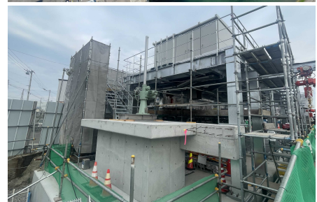
改築中の港町雨水ポンプ場
