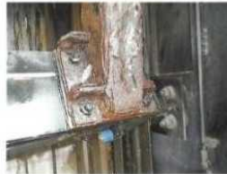
老朽化した自動除塵機 (千拓ポンプ場)
