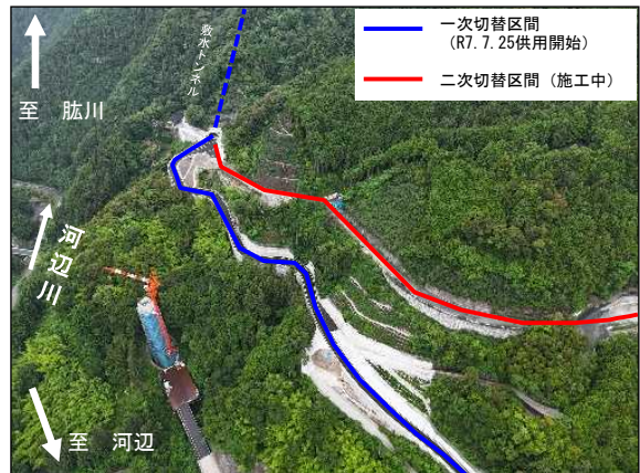
付替道路工事
