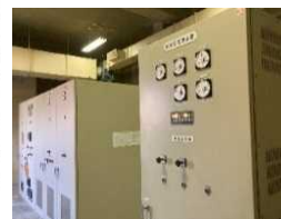
老朽化した電気設備 (唐樋ポンプ場)
