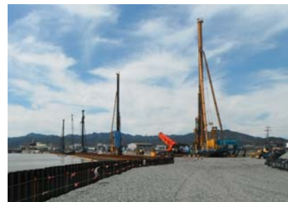
施工状況(サンドコンパクションパイル工法)
