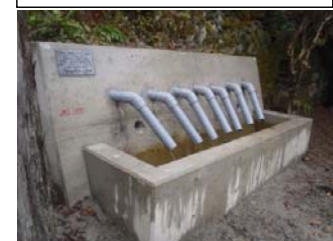
地すべり防止施設の例(横ボーリング工)
