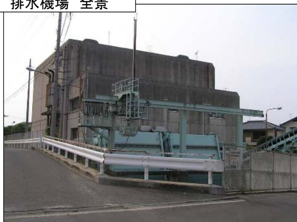
排水機場 全景
