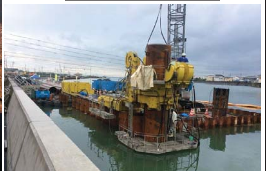
周辺施工状況
