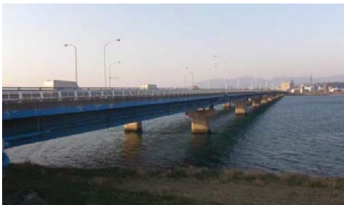
▲吉野川大橋 全景(完成後44年経過)
