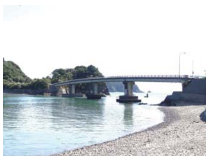
▲中ノ島大橋 (供用から34年経過)
