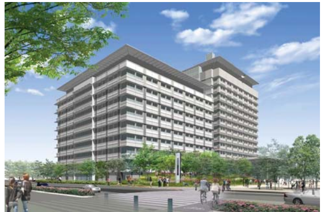
高松地方合同庁舎(手前がⅡ期・南館)
