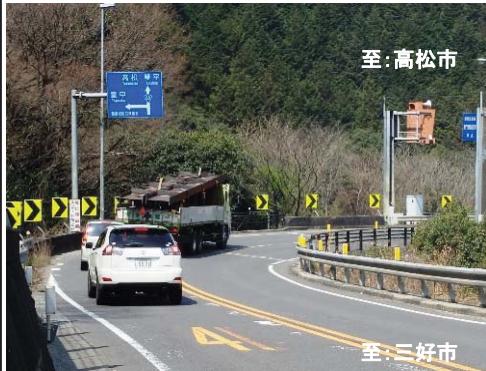
急カーブによる車両の逸脱状況
