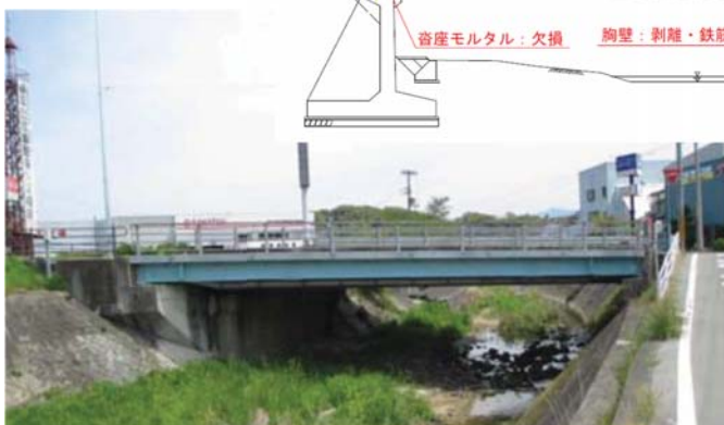
▲五条橋全景(完成後52年経過)
