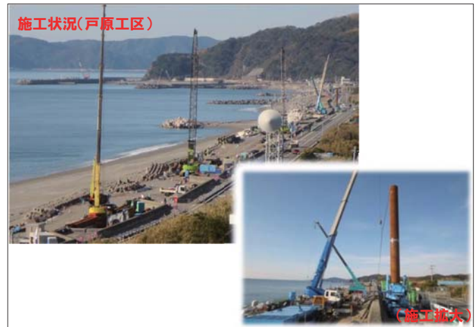
対策工事の様子（戸原工区）
