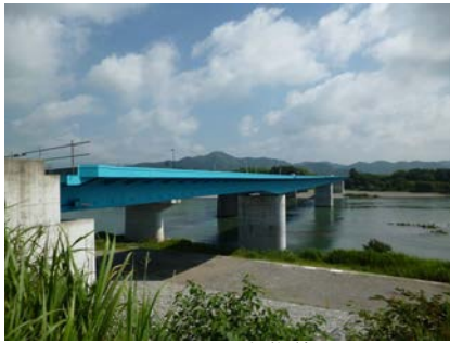
工事が進む仁淀川大橋 (高知市春野町弘岡上付近)
