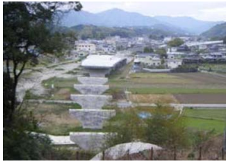
工事が進む日比宇高架橋 (徳島市上八万町広田付近)
