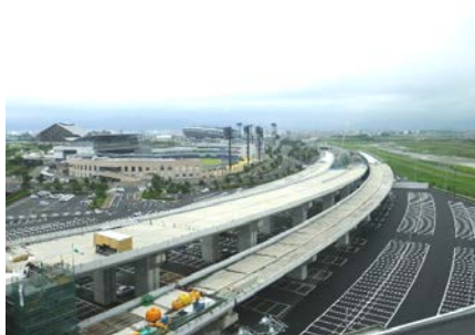
工事が進む松山中央公園高架橋 (松山市市坪西町付近)
