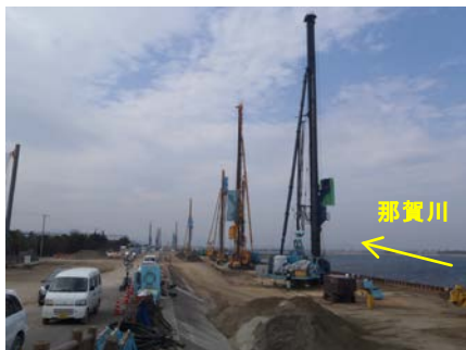
液状化対策施工の様子
