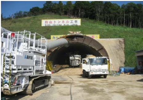
工事が進む前山トンネル (東かがわ市川東付近)
