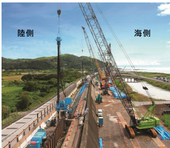
耐震・液状化対策施工の様子
