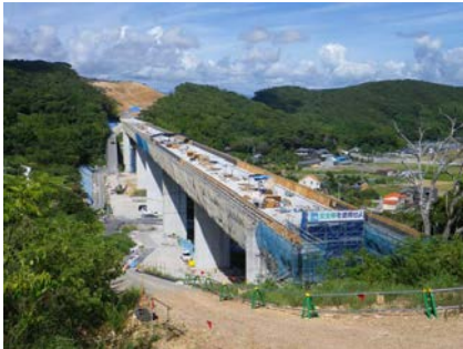
工事が進む衣笠高架橋 (南国市稲生付近)
