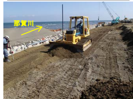
堤防嵩上げ施工の様子
