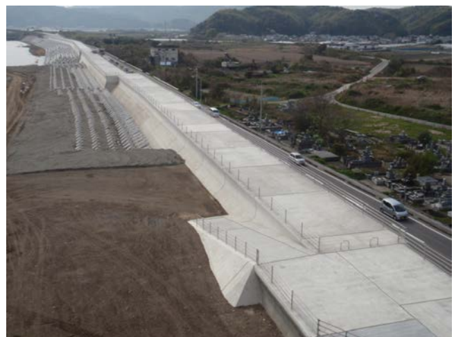
完成写真(仁ノ工区)
