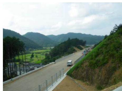
工事の進む四国横断自動車道 (高岡郡四万十町本田付近)
