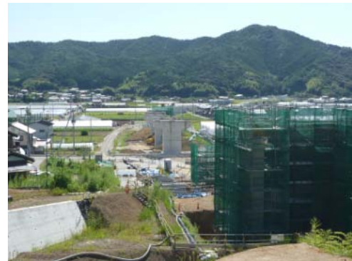
工事の進む南国安芸道路 (香南市夜須町出口付近)
