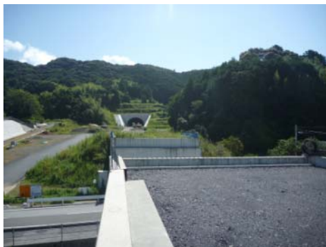
工事の進む南国安芸道路 (香南市香我美町徳王子付近)
