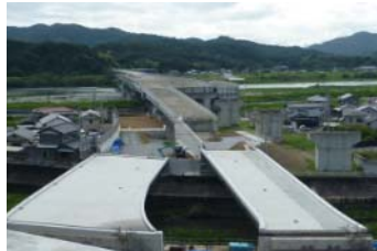
工事の進む高知西バイパス （吾川郡いの町天神付近）
