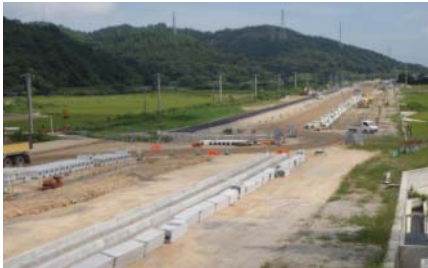
工事の進む新居浜バイパス (新居浜市萩生付近)
