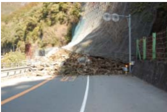
平成23年2月26日被災状況 (吾川郡仁淀川町名野川付近)
