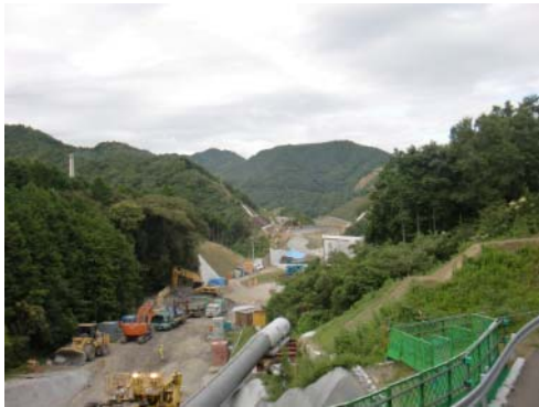
工事の進む宇和島道路 (宇和島市津島町高田付近)
