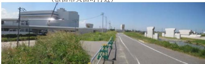
工事の進む松山外環状道路インター線 (松山中央公園高架橋～石手川橋)
