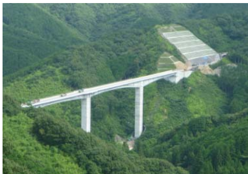
工事の進む四国横断自動車道 (高岡郡中土佐町久礼付近)
