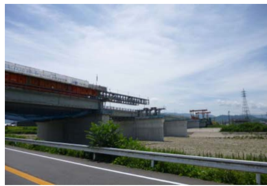
工事の進む綾南・綾歌・満濃バイパス (祓川大橋)
