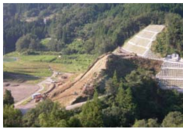
工事の進む猪ノ鼻道路 (三好市池田町 込野付近)
