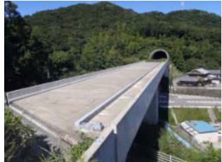
工事の進む阿南道路 (阿南市 橋町江ノ浦付近)
