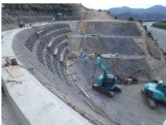
工事の進む徳島南環状道路 （徳島市一宮町僧津山付近）
