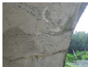
坑口部のコンクリートのひびわれ
