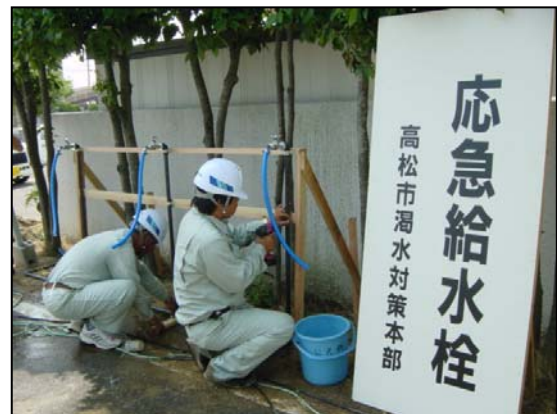
応急給水栓設置状況(平成17年度高松市)
