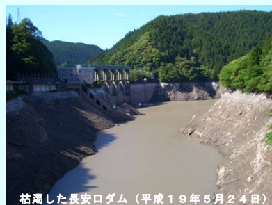
枯渇した長安口ダム（平成19年5月24日）
