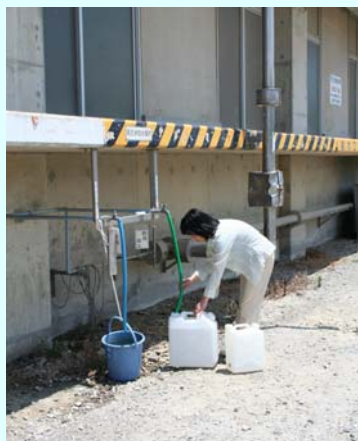
再生水取水施設からの取水状況
