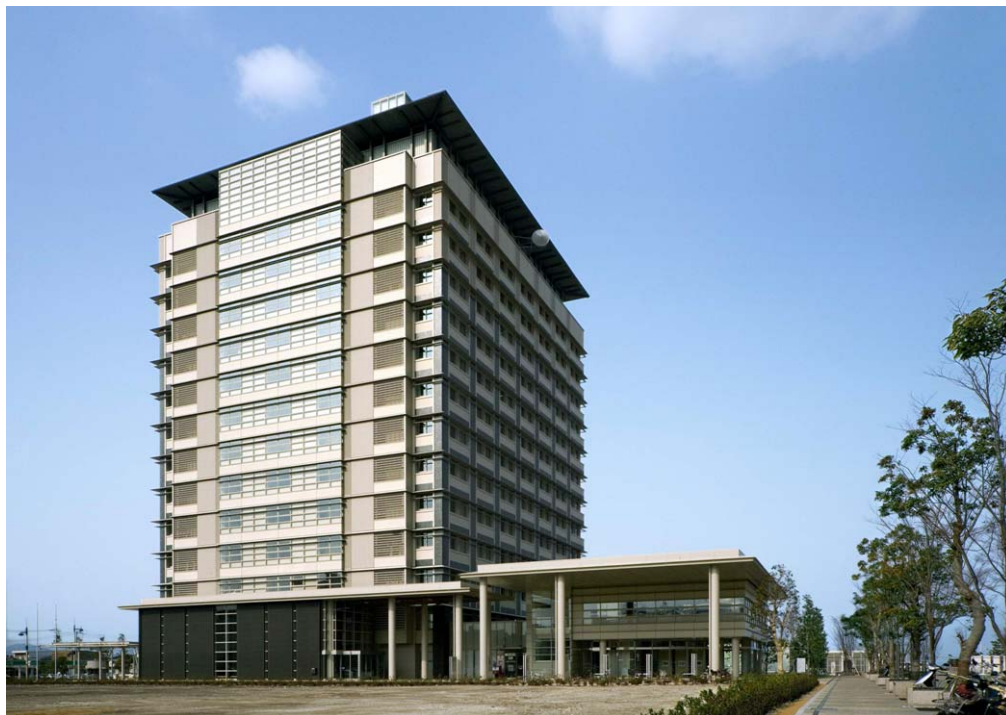
高松サンポート合同庁舎（Ⅰ期工事分（A棟））
