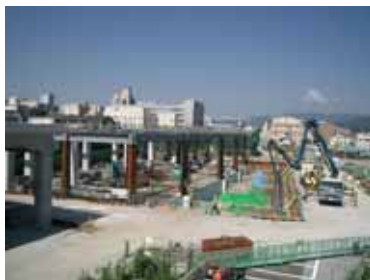
【高知駅周辺整備状況】
