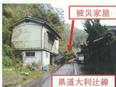
地すべり災害発生状況
