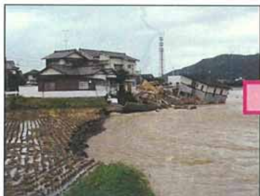
平成 16 年浸水被害状況
