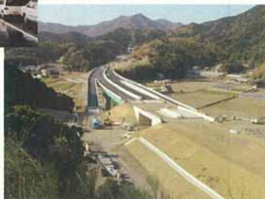
整備の進む日和佐道路（由岐IC付近）
