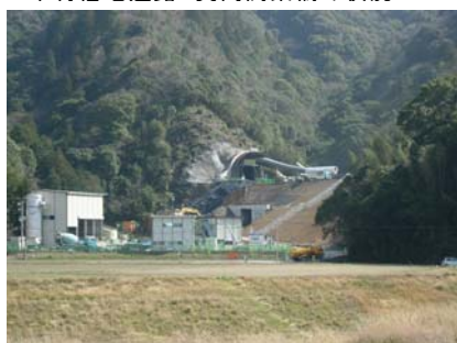
工事の進む中村宿毛道路
