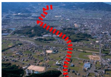
国道11号大内白鳥バイパス
