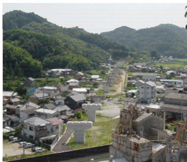
工事の進む高知南国道路 (南国市稲生高架橋)
