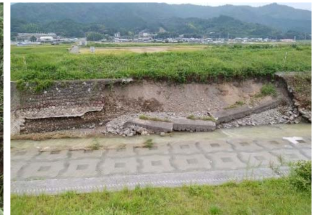
河川管理施設の被災状況
