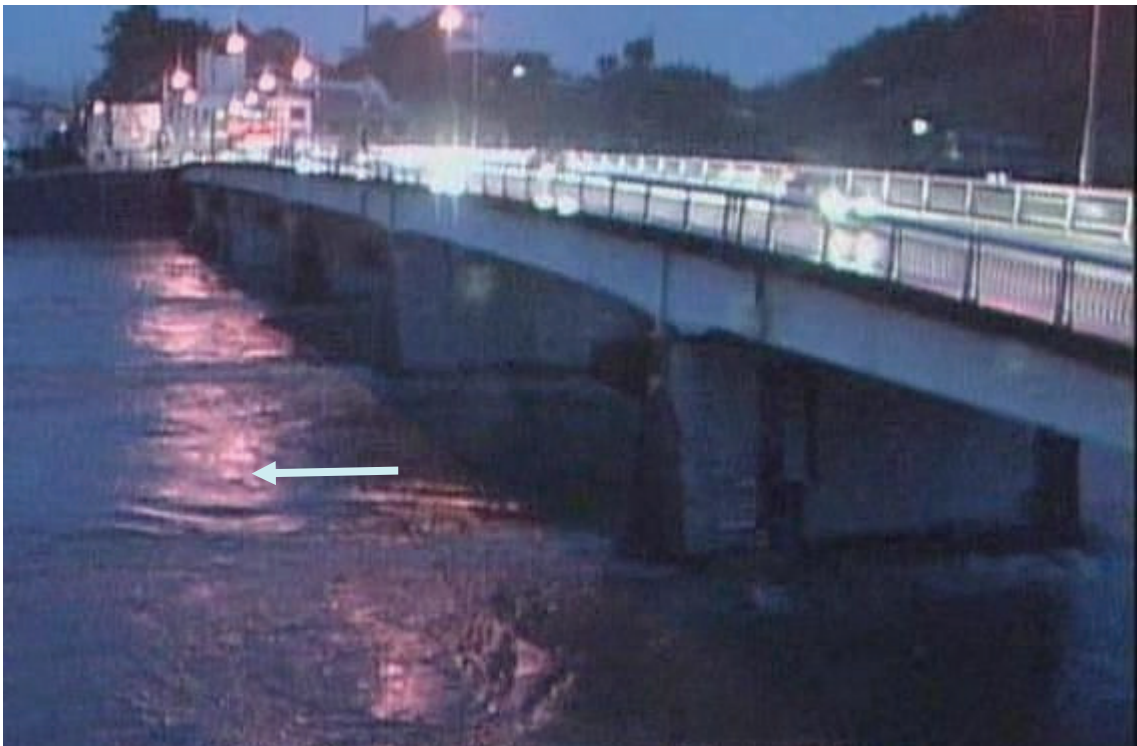
▲ 肱川橋 (肱川河口から 18.7 km 付近) (平成 23 年 9 月 20 日 18 時 25 分頃)
