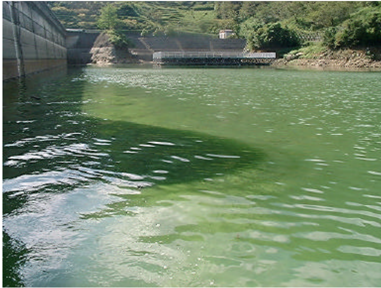
貯水池堰堤付近
