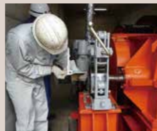
放流設備の点検・補修
