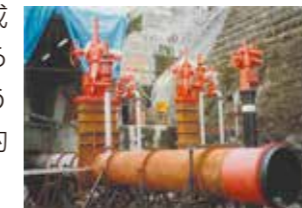
放水管の設置工事
