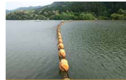
③ 流木止設備
