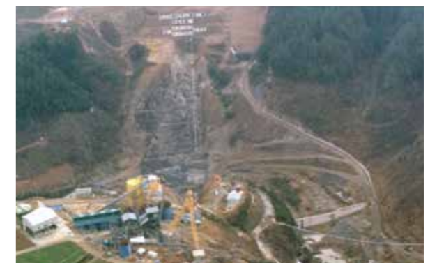
ダム建設工事(全景)
