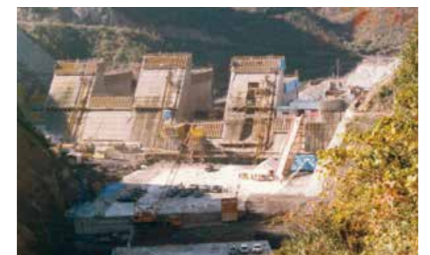
ダム建設工事(ダムサイト)
