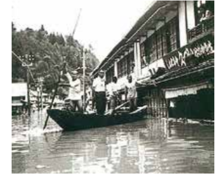
昭和18年 大洲地区浸水状況
