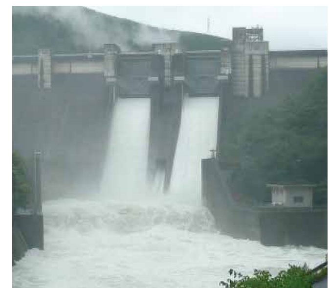
クレストゲートからの放流
