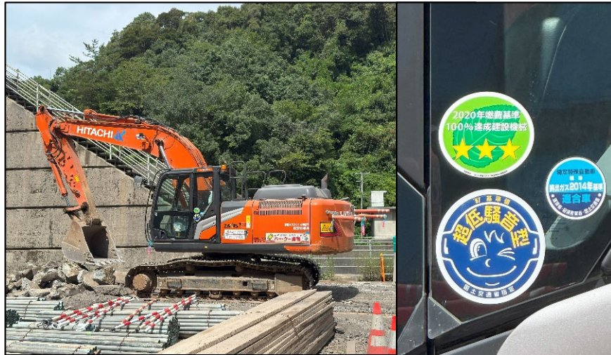
排出ガス対策型・低騒音型建設機械
