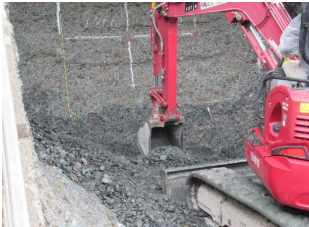
削孔ズリ発生状況
