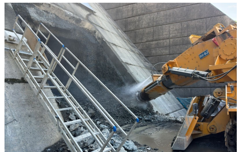
堤体削孔時の散水状況
