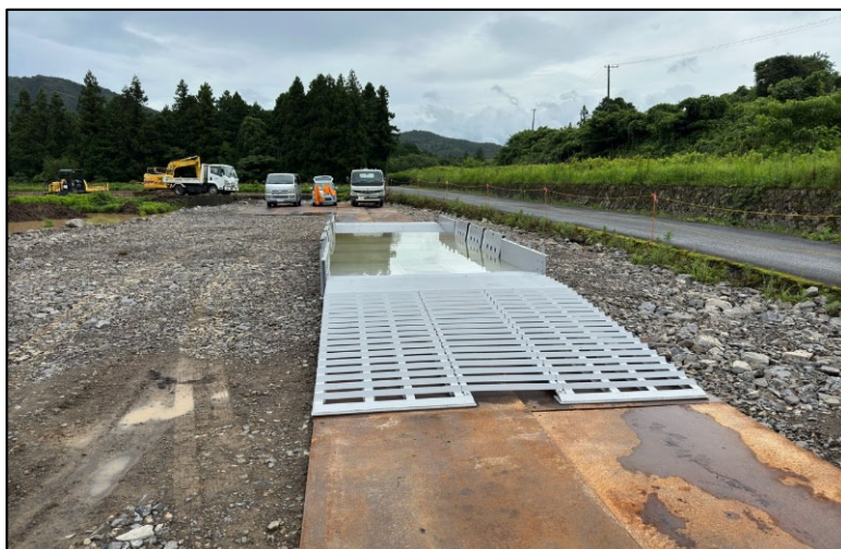
土砂仮置き場でのタイヤ洗浄装置
