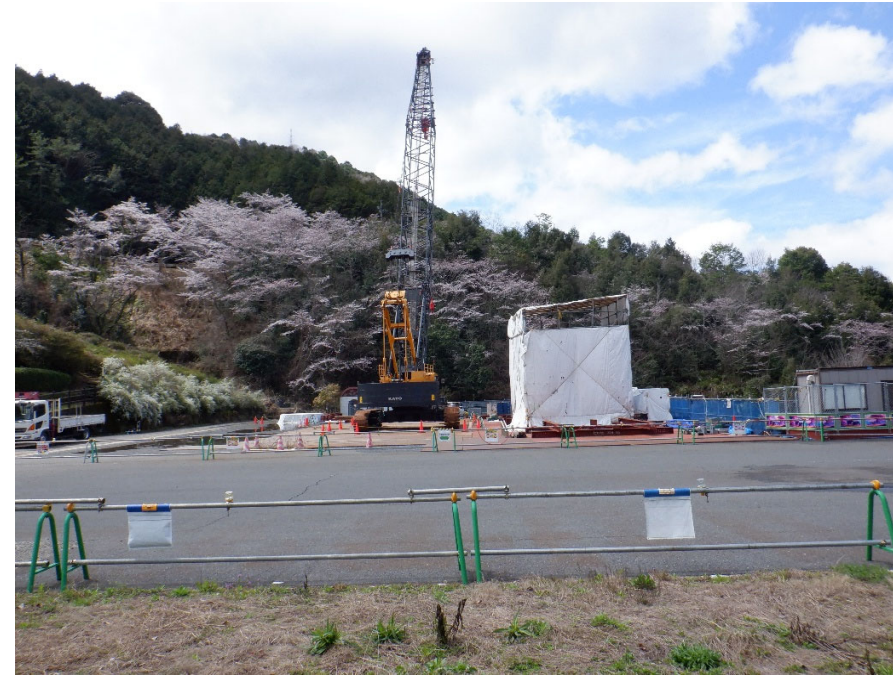
右岸上流仮設構台（曲管組立）
